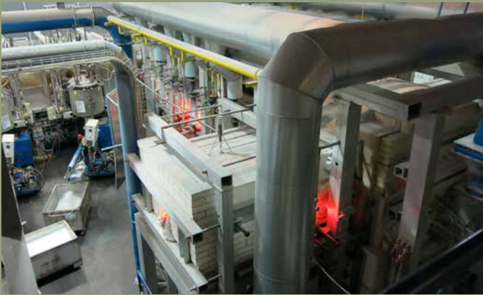
A Preciosa Ornela, a.s. Facility
